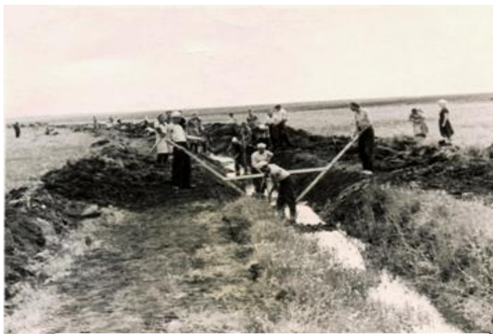
Рис.2.Формування каналу вручну, 1956 р.
