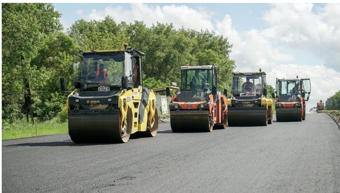
Рис. 3.3. Ремонт об'їзної дороги на околиці Тернополя
