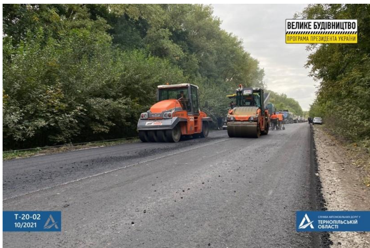
Рис. 3.1. Ремонт територіальної дороги (автошляху Т-20-02 Тернопіль-Скалат-Жванець) на ділянці між Смиківцями і Гримайловом.
