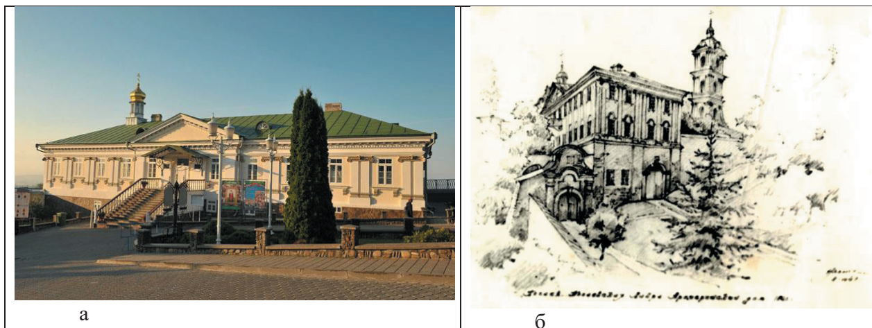
Рис.3. Архієрейський будинок (1820-1825 рр.): а – сучасний вигляд (фото з сайту: www.google.com.ua ); б – малюнок Леоновича (?) 1949 р. (фото з архіву Тернопільського обласного відділу в справах будівництва та архітектури)
