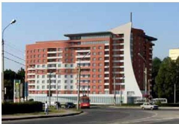
Рис. 1. Житлово-громадський комплекс “Арго” по вул. Протасевича (архітектор В. Гой).
