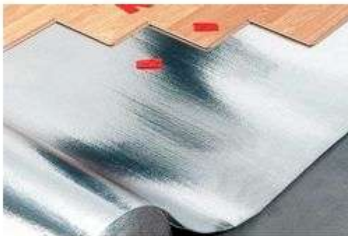
Рис. 2. Утеплення підлоги за допомогою пенофола.
